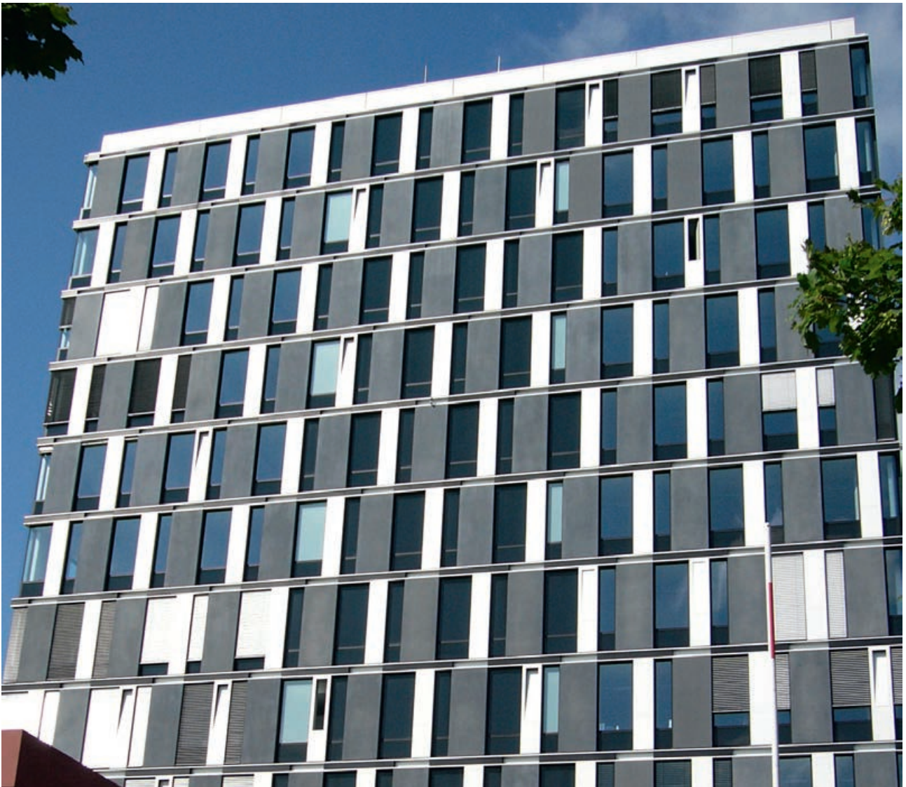
Science Park Saar, Saarbrücken, Ausführung: ISOLAR VACUREX® // Foto: © ISOLAR
