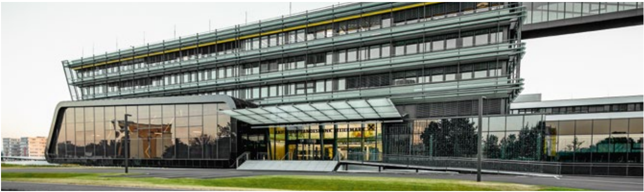
Raiffeisen Multifunktionsgebäude, Raaba, Ausführung ISOLAR NEUTRALUX® advance // Foto: © Arnold Glas
