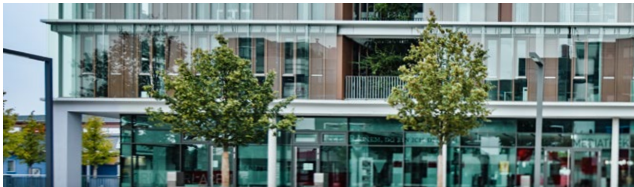
Rathaus Raunheim, Ausführung: ISOLAR AKUSTEX® advance //, 45 dB, Foto: © Arnold Glas
